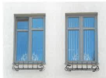
Neubau in Anlehnung an das historische Erscheinungsbild
