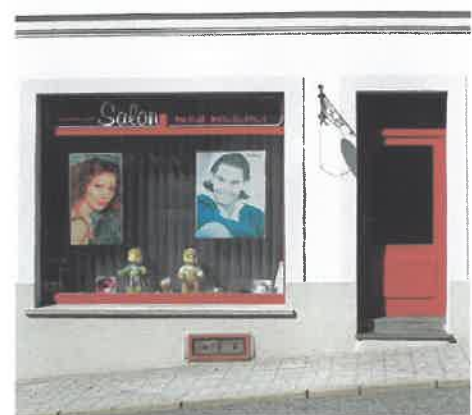
Typische Schaufenstergliederung mittels glasteilender Sprossen sowie in oder vor die Fensterfläche gestellter Säulen.
