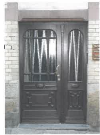
Zweiflügelige Tür mit Dreh- und Standflügel
