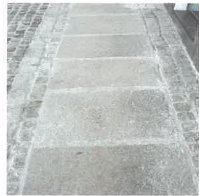
Breite Gehwegplatten und Traufzeilen aus Granit sind typisch für die Reichenbacher Altstadt.
