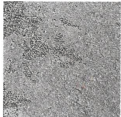
Wassergebundene Decken stellen eine einfache Form der Oberflächenbefestigung dar und ermöglichen die Versickerung des Regenwassers.
