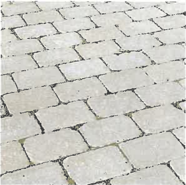
Betonpflastersteine sollten sich in Größe und Format an Granitsteinen orientieren.
