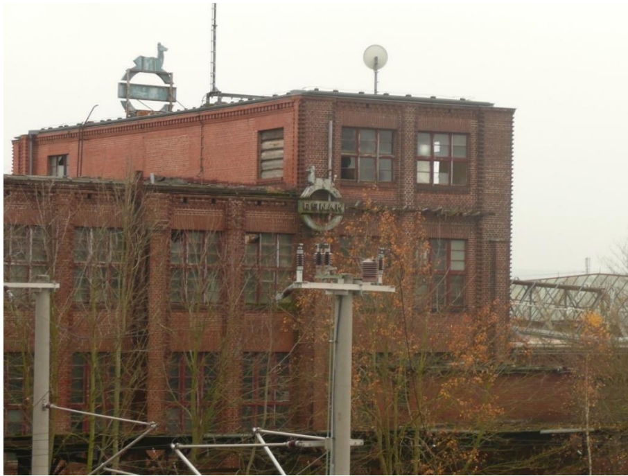
Abbildung 19 altes Industriegebäude Renak in Reichenbach im Vogtland (Quelle: Eigene Aufnahme, 2021).
