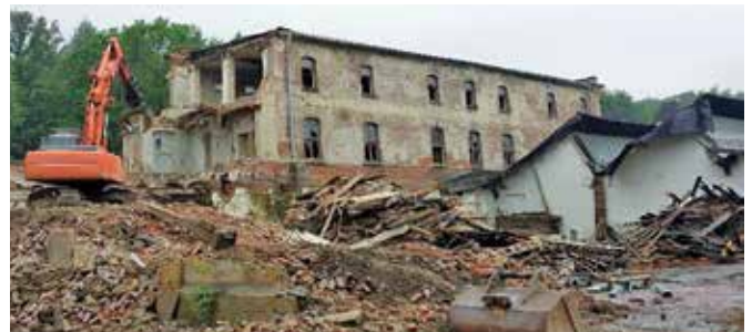
Rückbau durch die Firma Kran Held im Ortsteil Mylau, Karl-Marx-Ring 10
