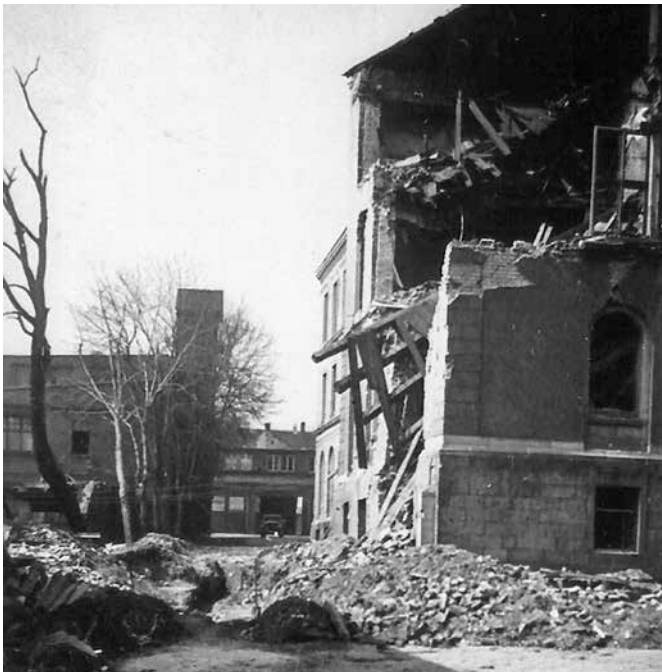
Beschädigtes Rathaus und beschädigte Weinholdschule (Sammlung Werner Nitzschke)
