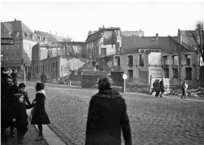
Zerstörtes Wohn- und Geschäftshaus Köbel (Digitales Bildarchiv Gero Fehlhauer)
