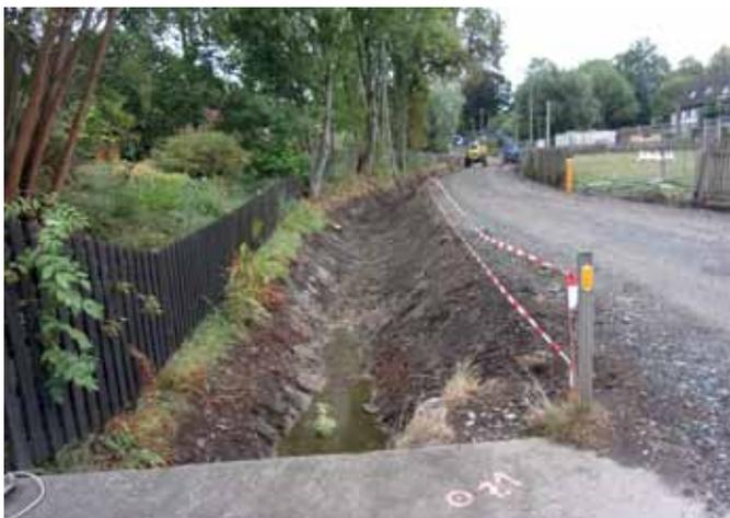
Das Bauvorhaben beinhaltet als ersten Teilabschnitt den grundhaften Ausbau der Fahrbahn Friesener Weg auf einer Länge von ca. 160 Meter ab Einmündung Pestalozzistraße bis zur Grundstückszufahrt Reiterhof in Cunsdorf. Der rechte Seitengraben und der verrohrte Abschnitt der Oberflächenentwässerung bis zur Kreuzung Pestalozzistraße werden erneuert. Der außerhalb, südwestlich des Baufeldes befindliche verrohrte Abschnitt wird punktuell instand gesetzt.
