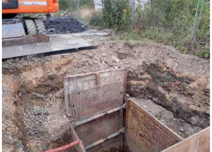
Als vorbereitende Maßnahme zum Abbruch und Ersatzneubau der Brücke am Karl-Marx-Ring in Mylau im Rahmen der Beseitigung der Hochwasserschäden von 2013 ist es notwendig, vor Abriss des Brückenbauwerkes die Trinkwasserversorgung der Anlieger des Karl-Marx-Ringes zu sichern. Dafür muss die Wasserleitung vor Abbruch und Neubau der Brücke am Karl-Marx-Ring umverlegt werden.
