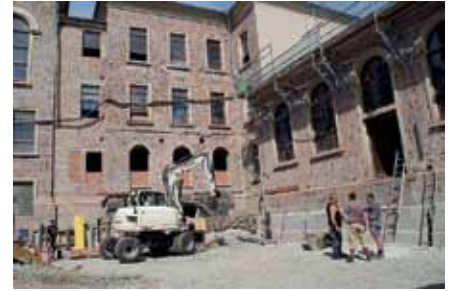
Glasfassade und einer Stahlbetonkonstruktion den Lückenschluss zwischen Schule und Mensa herstellt.
