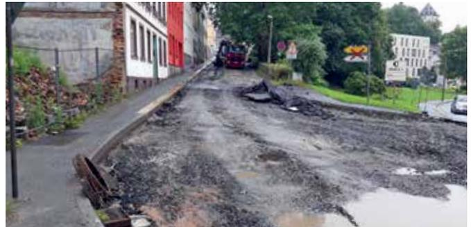
Im Anschluss an den Bau der Hainstraße beginnen die Arbeiten am Friedenshain. Auch hier werden die Trink- und Abwasserleitungen erneuert. Im Bereich des Friedenshains wird im Auftrag des Landratsamtes des Vogtlandkreises nach dem Leitungswechsel der Fahrbahnbelag auf einer Länge von ca. 75 Metern erneuert. Die Stadt Reichenbach ist Auftraggeber für den Bau der linken Gehwegseite am Friedenshain. Die Arbeiten dauern voraussichtlich bis Ende November.
