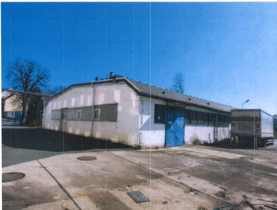
Blick auf die nördlich und westlich orientierten Gebäudefassaden
