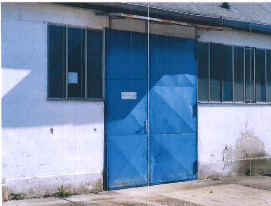
Blick auf das zweiflüglige Bestandstor an der westlich orientierten Gebäudeseite
