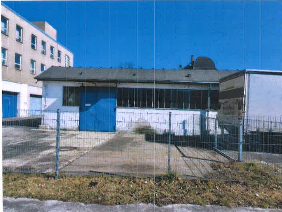
Blick auf einen Bereich der westlich orientierten Gebäudefassade
