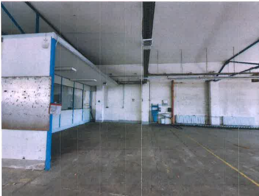
Weiterer Blick in die Halle (nordöstlicher Gebäudebereich)
