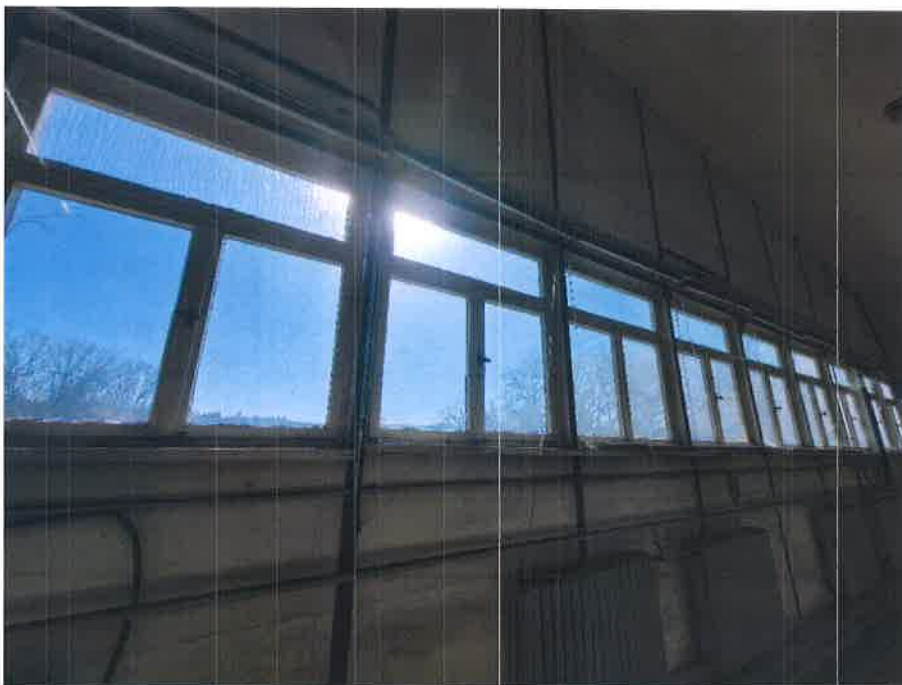
Blick auf das Fensterband (Bestandsholzfenster)
