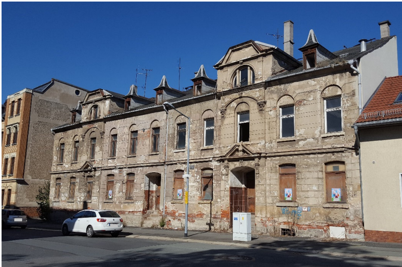
Gebäude Fedor-Flinzer-Straße 17/19 (Aufnahme aus 2020)
