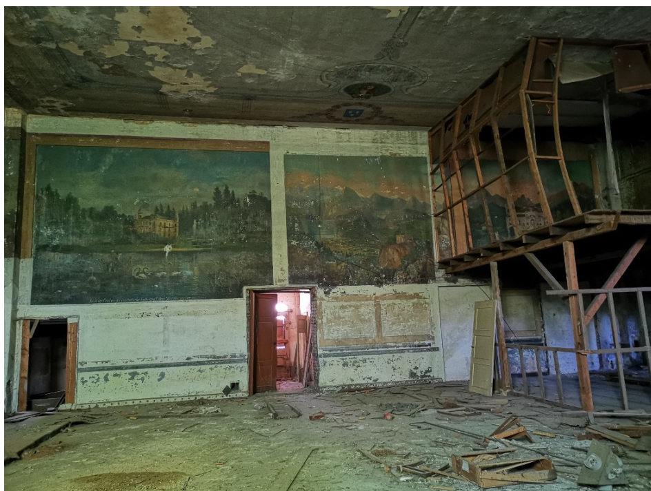
Bilder im Ballsaal vor Abbruch
