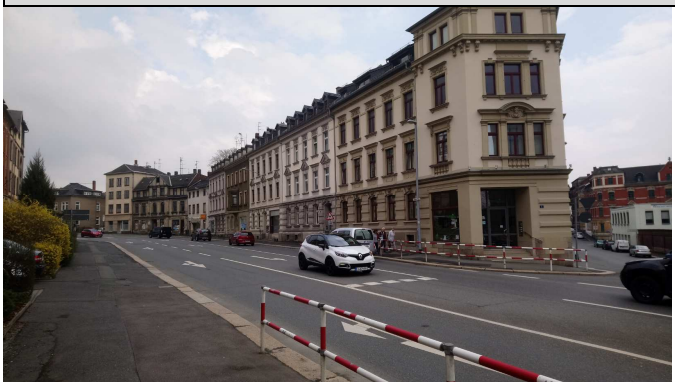
nördliche Bebauung aus Richtung Westen
