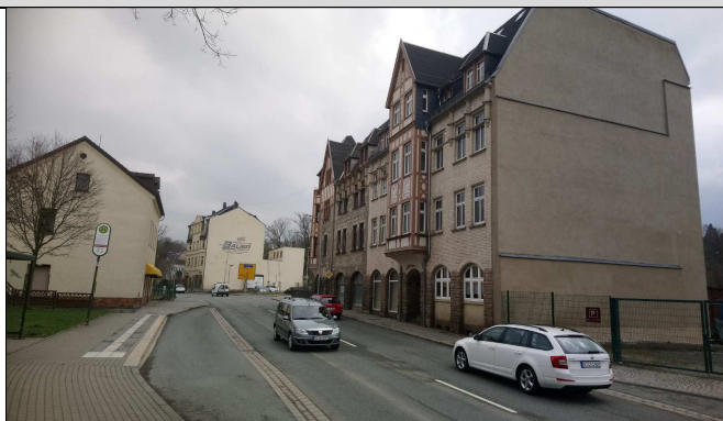
südliche Bebauung aus Richtung Nordwesten
