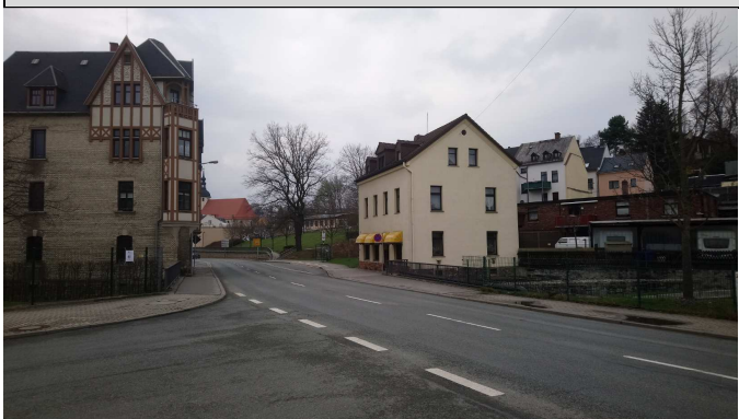
nördliche Bebauung aus Richtung Südosten
