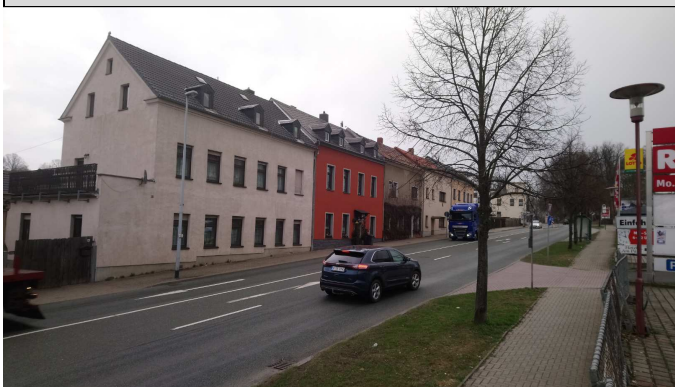
nördliche Bebauung aus Richtung Westen
