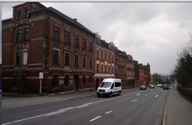
nordöstliche Bebauung aus Richtung Nordwesten
