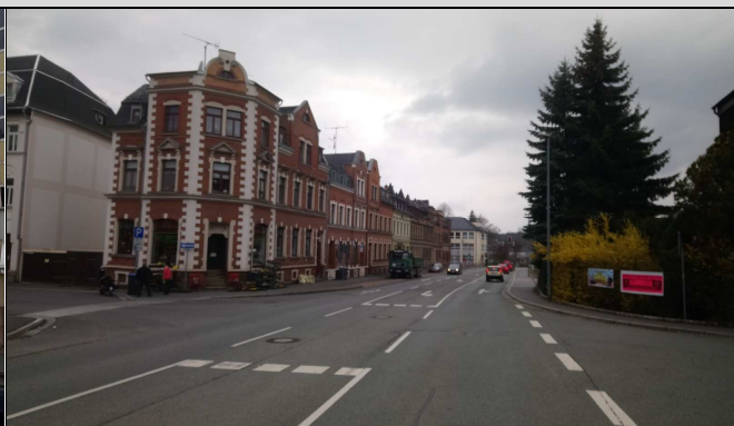
südliche Bebauung aus Richtung Osten
