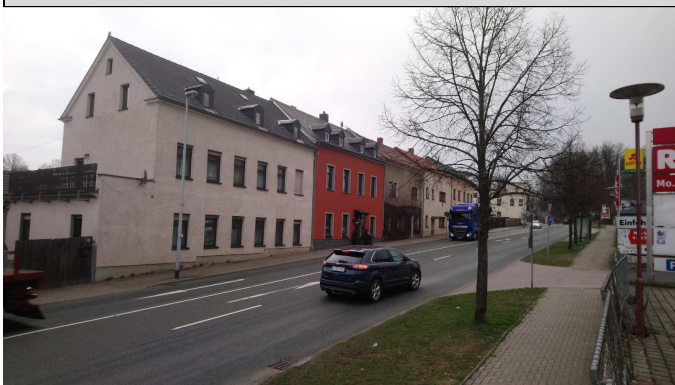
nördliche Bebauung aus Richtung Westen
