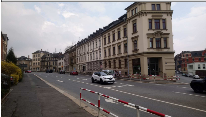
nördliche Bebauung aus Richtung Westen
