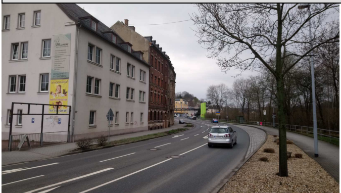
nördliche Bebauung aus Richtung Westen
