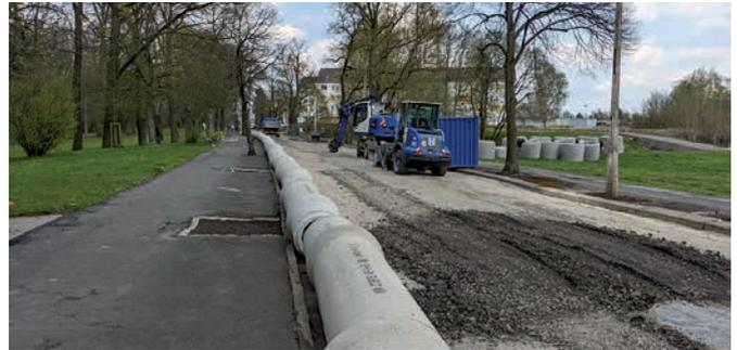
In der Agnes-Löschler-Strasse in Reichenbach werden gegenwärtig in zwei Bauabschnitten Abwasserkanal, Trinkwasserleitung und Gasleitung erneuert. Bauausführendes Unternehmen ist die Hoch- und Tiefbau Reichenbach GmbH.
