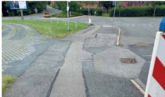
Vor dem Bau: der Fußweg als Stolperfalle
