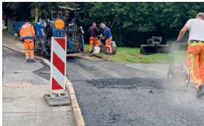
Die Firma Hoch- und Tiefbau Reichenbach GmbH beim Asphaltbau.
