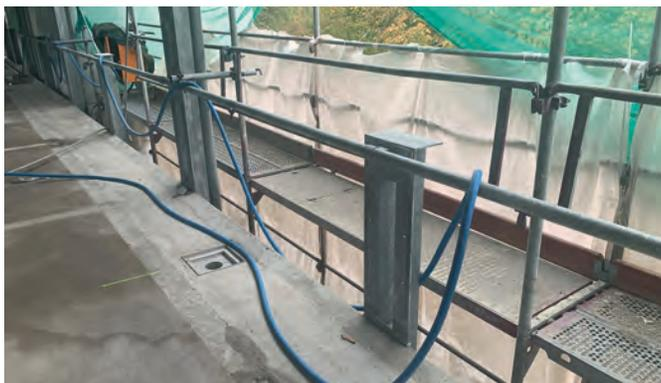
Die abgebrochenen Bereiche der Deckenplatten (Randbereiche mit Entwässerungsrinnen) wurden betoniert. Wenn die Temperaturen es zulassen und vor allem der Dezember nicht zu nass ist, können die Arbeiten auf der Seite zum Park des Friedens abgeschlossen werden.
