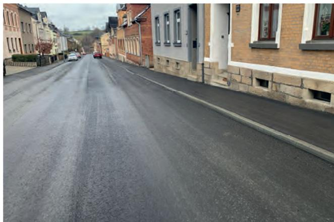
Die Firma Hoch- und Tiefbau Reichenbach GmbH führte auf der linken Seite stadtauswärts eine Teilsanierung der Straße durch. Gleichzeitig wurden die Bordsteine im Baubereich reguliert sowie die Straßenabläufe instandgesetzt. Auch der Gehweg von der Hausnummer 57 bis zur Hausnummer 81 wurde erneuert.
