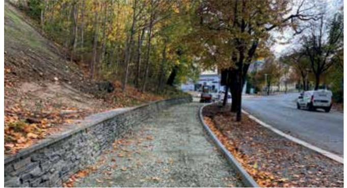
Im Oktober/November erfolgte der Fußwegbau auf der Bahnhofstraße im Abschnitt Humboldtstraße bis Kreisverkehr. In den Fußweg wurden Ver- und Entsorgungsleitungen verlegt. Leitungen wurden auch von der Baustelle des Güterbahnhofes in den Fußweg eingebracht. Der Gehweg erhält zweifarbiges Betonpflaster mit taktilen Elementen. Zur Anbindung der Leitungen wurde zeitweise die Klinkhardtstraße im oberen Bereich zur Bahnhofstraße voll gesperrt.
