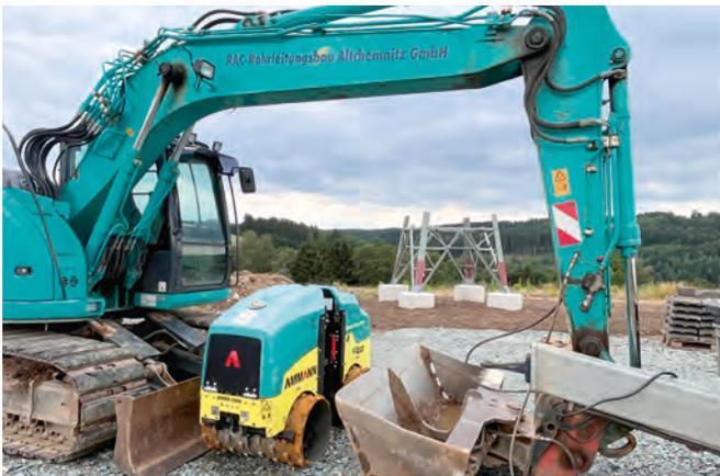
Breite Schneisen durchschneiden die Felder bei Rotschau. Auf ihnen rollen Bagger, Lkw und Betontransporter. Fundamente und der Unterbau für neue Strommasten werden gesetzt.
