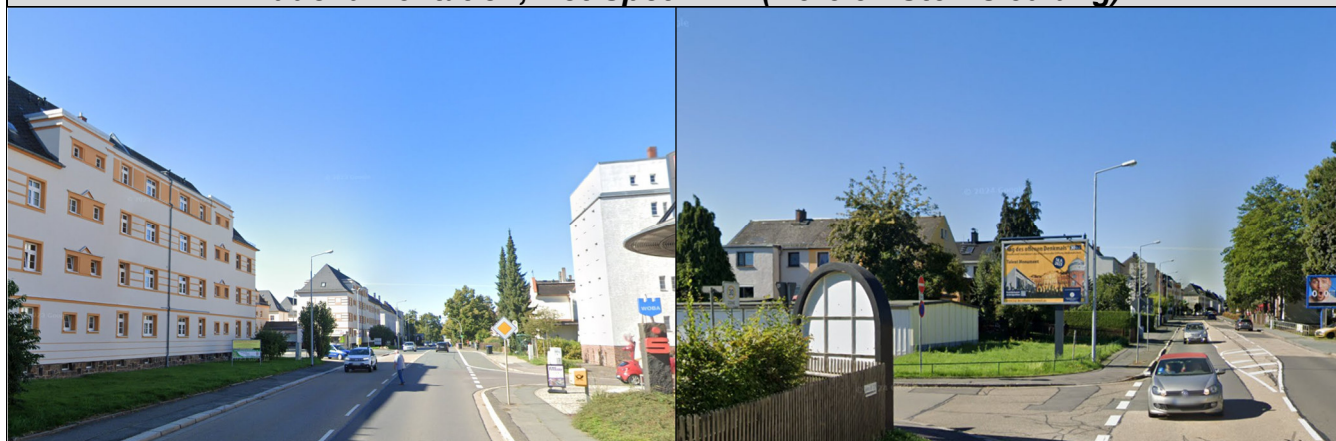
Bebauung aus Richtung Südwesten
