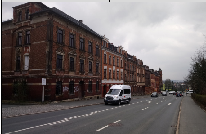
nordöstliche Bebauung aus Richtung Nordwesten
