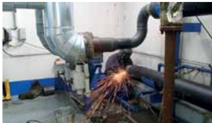
Arbeiten zur Einbindung der Fernwärmetrasse im Heizwerk.
