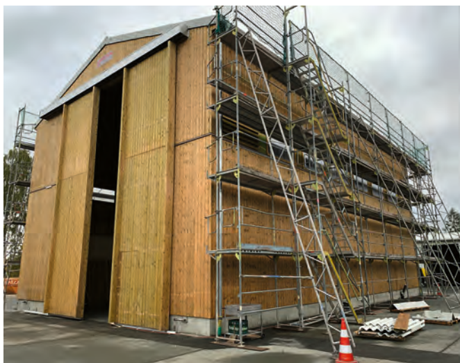
Die neue Salzlagerrhalle.
